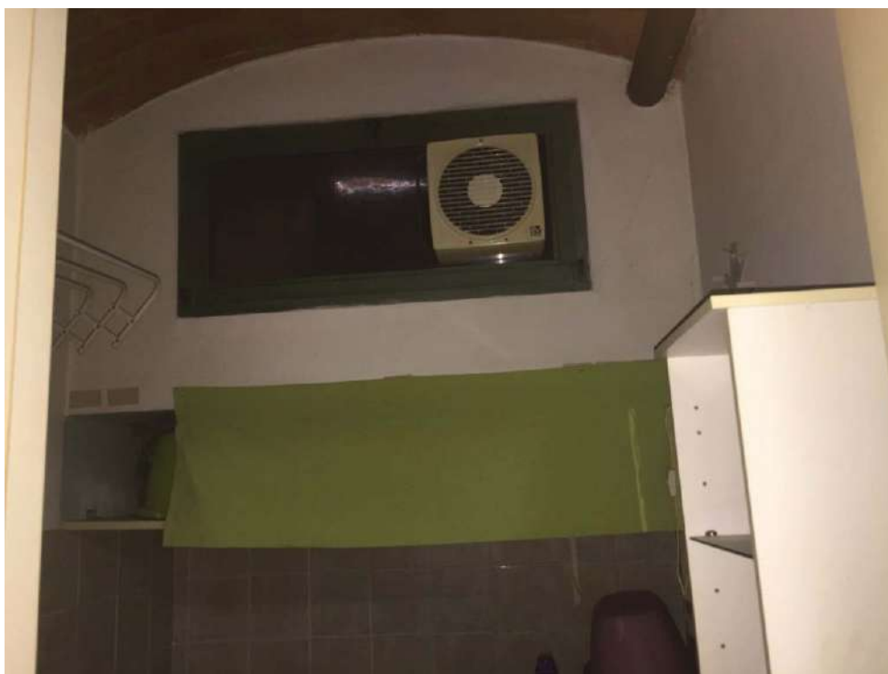
Foto n.14 – Finestrelle fronte strada (bocche di lupo)
