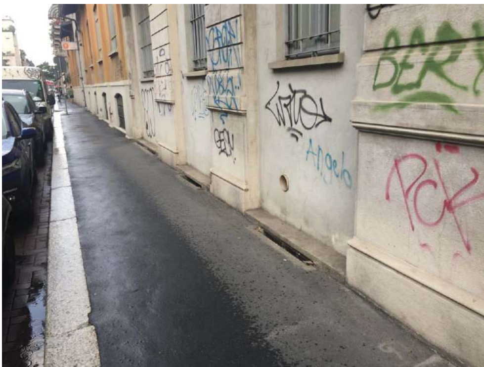
Foto n.2 – Prospetto lato strada (bocche di lupo)
